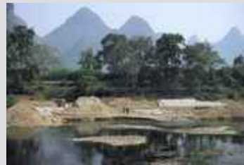
Bau von Uferbefestigungen zum Hochwasserschutz.
