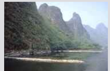
An wenigen Stellen sieht man auffallend ausgeprägte Bühnen zur Verbesserung der Schifffahrt.
