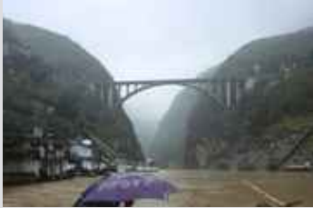
Daning-Fluss: Einfahrt in die 3 km lange Longmen-Schlucht", die erste der 3 kleinen Schluchten"
