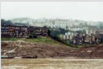
Nach der Fertigstellung des Projektes wird die bisherige Kreisstadt Wushan vollständig überflutet, aber die Neuerrichtung an höherer Stelle ist schon weit vorangeschritten.
