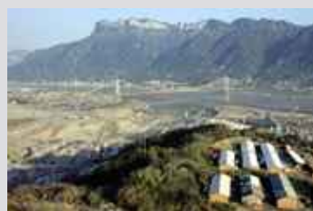
Blick vom Aussichtspunkt auf die Schleusentreppe stromabwärts, im Vordergrund Wohnsiedlung der Arbeiter, im Hintergrund die Stadt Yichang
