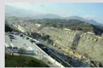
Wenn man in die entgegengesetzte Richtung schaut, erkennt man, dass die Schleusentreppe tief in den Berg gehauen wurde.
