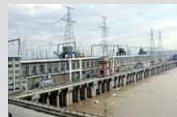
Ge Zhouba-Damm, vom Unterwasser aus gesehen
